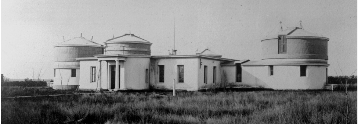
Vista noreste del edificio del Observatorio Nacional Argentino aproximadamente en 1873
